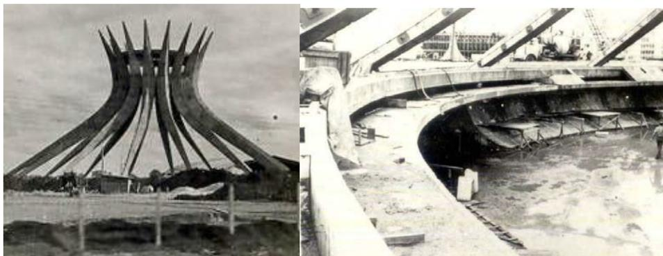
Figura 14: Estrutura dos pilares e detalhe da construção do anel de tração na base da Catedral de Brasília, 1959. Foto : Marcel Gautherot.
