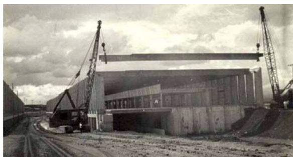
Figura 19: Montagem das vigas pré-moldadas da cobertura do ICC.
