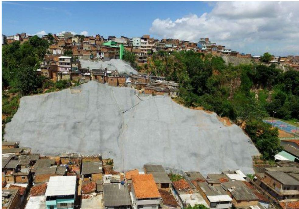
Figura 5: Geomanta no Arraial do Retiro. (Fonte: Pontes, 2018).
