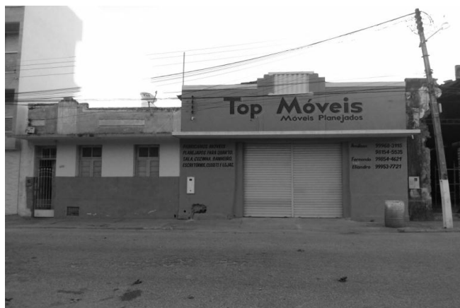
Figura 9 – Residência e antiga residência transformada em comércio remanescente do estilo Art Decó em São Fidélis. Fonte: acervo do autor, 2014.
